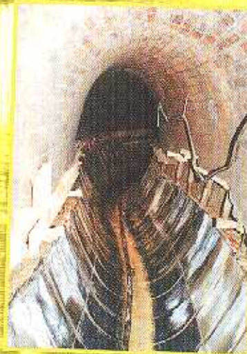
Sanierung des Kanalsammlers „Trojská“ mit Rinne und Seitenwänden aus Schmelzbasalt
