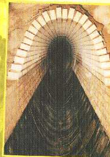
Sanierung des Kanalsammlers „Trojská“ mit Rinne und Seitenwänden aus Schmelzbasalt
